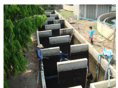
รูปภาพแสดง : เจ้าหน้าที่หน่วยกำจัดน้ำเสียปฏิบัติงานล้างทำความสะอาดบ่อตกตะกอนเนื่องจากใบกวาดก้นบ่อตกตะกอน ชำรุด
