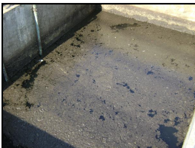
รูปภาพแสดง : เจ้าหน้าที่หน่วยกำจัดน้ำเสียปฏิบัติงานล้างทำความสะอาดบ่อตกตะกอนเนื่องจากใบกวาดก้นบ่อตกตะกอน ชำรุด
