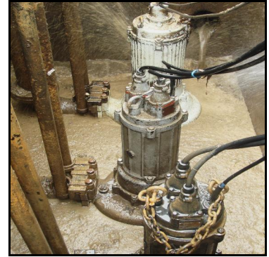
รูปภาพแสดง : เครื่องสูบน้ำขนาด 20 แรงม้า บ่อสูบน้ำ
