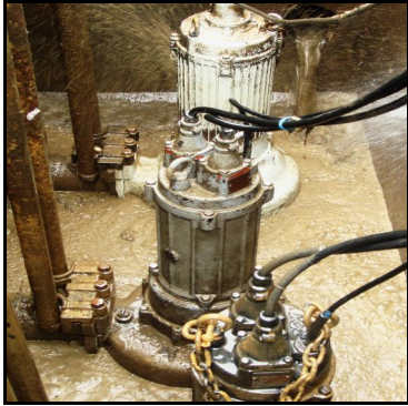
รูปภาพแสดง : เครื่องสูบน้ำขนาด 20 แรงม้า บ่อสูบน้ำ
