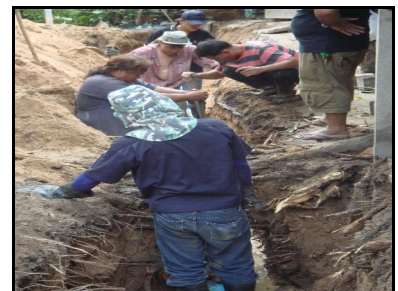
รูปภาพแสดง : การปฏิบัติงานวางเปลี่ยนแนวท่อน้ำเสีย ของ เจ้าหน้าที่หน่วยกำจัดน้ำเสีย
