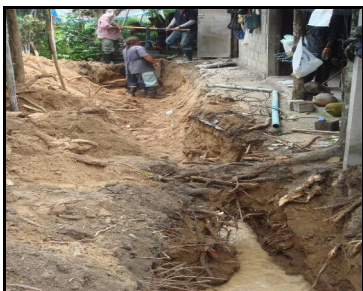
รูปภาพแสดง : การปฏิบัติงานวางเปลี่ยนแนวท่อน้ำเสีย ของ เจ้าหน้าที่หน่วยกำจัดน้ำเสีย
