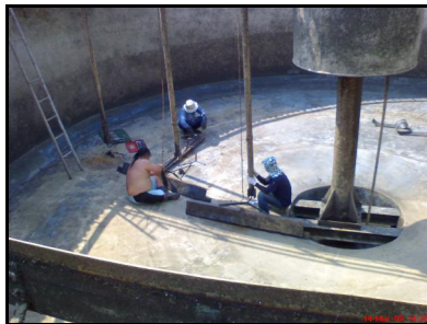
รูปภาพแสดง : เจ้าหน้าที่หน่วยกำจัดน้ำเสียปฏิบัติงานล้างทำความสะอาดบ่อตกตะกอนเนื่องจากใบกวาดก้นบ่อตกตะกอน ชำรุด
