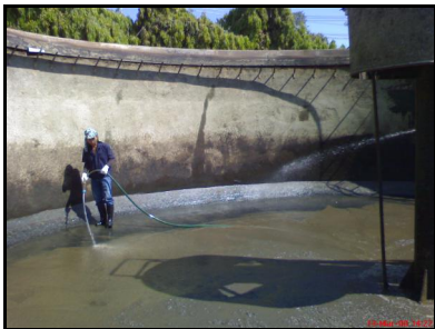
รูปภาพแสดง : เจ้าหน้าที่หน่วยกำจัดน้ำเสียปฏิบัติงานล้างทำความสะอาดบ่อตกตะกอนเนื่องจากใบกวาดก้นบ่อตกตะกอน ชำรุด
