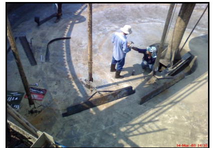
รูปภาพแสดง : เจ้าหน้าที่หน่วยกำจัดน้ำเสียปฏิบัติงานล้างทำความสะอาดบ่อตกตะกอนเนื่องจากใบกวาดก้นบ่อตกตะกอน ชำรุด
