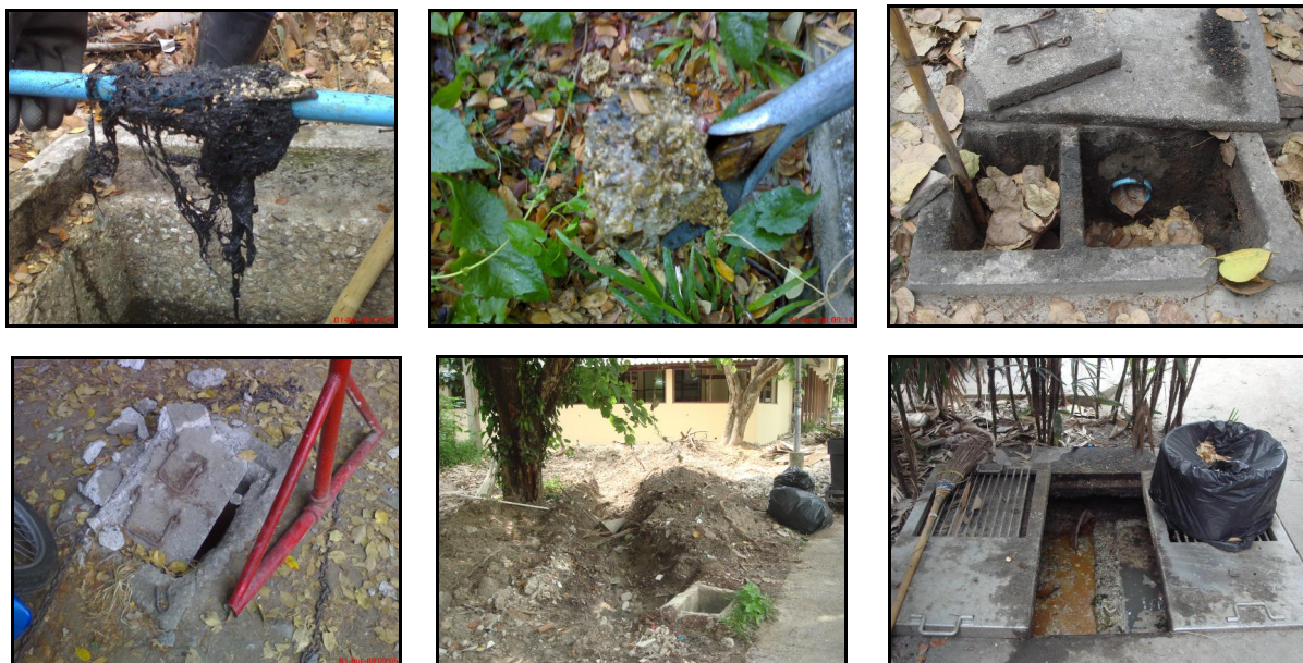
รูปภาพแสดง : สาเหตุที่ทำให้แนวท่อน้ำเสียอุดตัน
