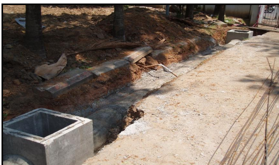
รูปภาพแสดง : การเปลี่ยนวางแนวท่อน้ำเสีย โดยผู้รับเหมาก่อสร้าง
