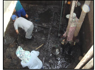
รูปภาพแสดง : การปฏิบัติงานเจ้าหน้าที่หน่วยกำจัดน้ำเสียปฏิบัติงานล้างทำความสะอาดภายในบ่อสูบ 1 (อ่างแก้ว)
