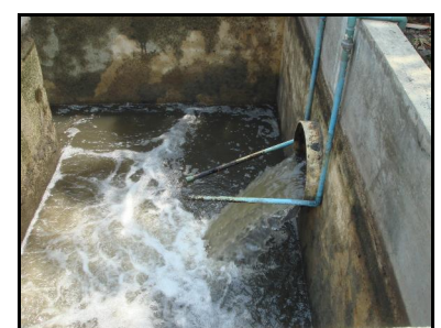
รูปภาพแสดง : การปฏิบัติงานเจ้าหน้าที่หน่วยกำจัดน้ำเสียปฏิบัติงานล้างทำความสะอาดบ่อคลอรีน
