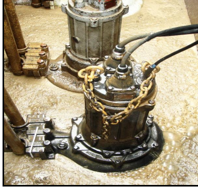
รูปภาพแสดง : เครื่องสูบน้ำขนาด 20 แรงม้า บ่อสูบน้ำ
