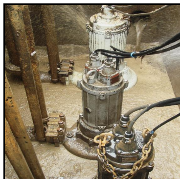
รูปภาพแสดง : เครื่องสูบน้ำเสีย ขนาด 15 แรงม้า
