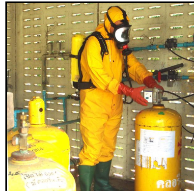
รูปภาพแสดง : การเปลี่ยนถังคลอรีน และคลอรีนรั่ว
