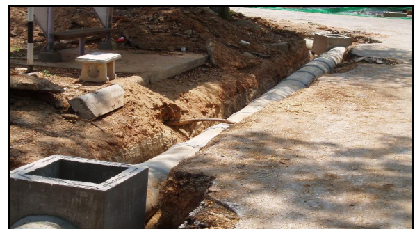
รูปภาพแสดง : การเปลี่ยนวางแนวท่อน้ำเสีย โดยผู้รับเหมาก่อสร้าง
