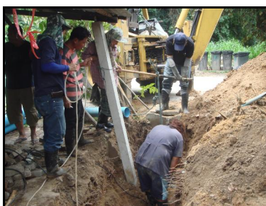
รูปภาพแสดง : การปฏิบัติงานวางเปลี่ยนแนวท่อน้ำเสีย ของ เจ้าหน้าที่หน่วยกำจัดน้ำเสีย
